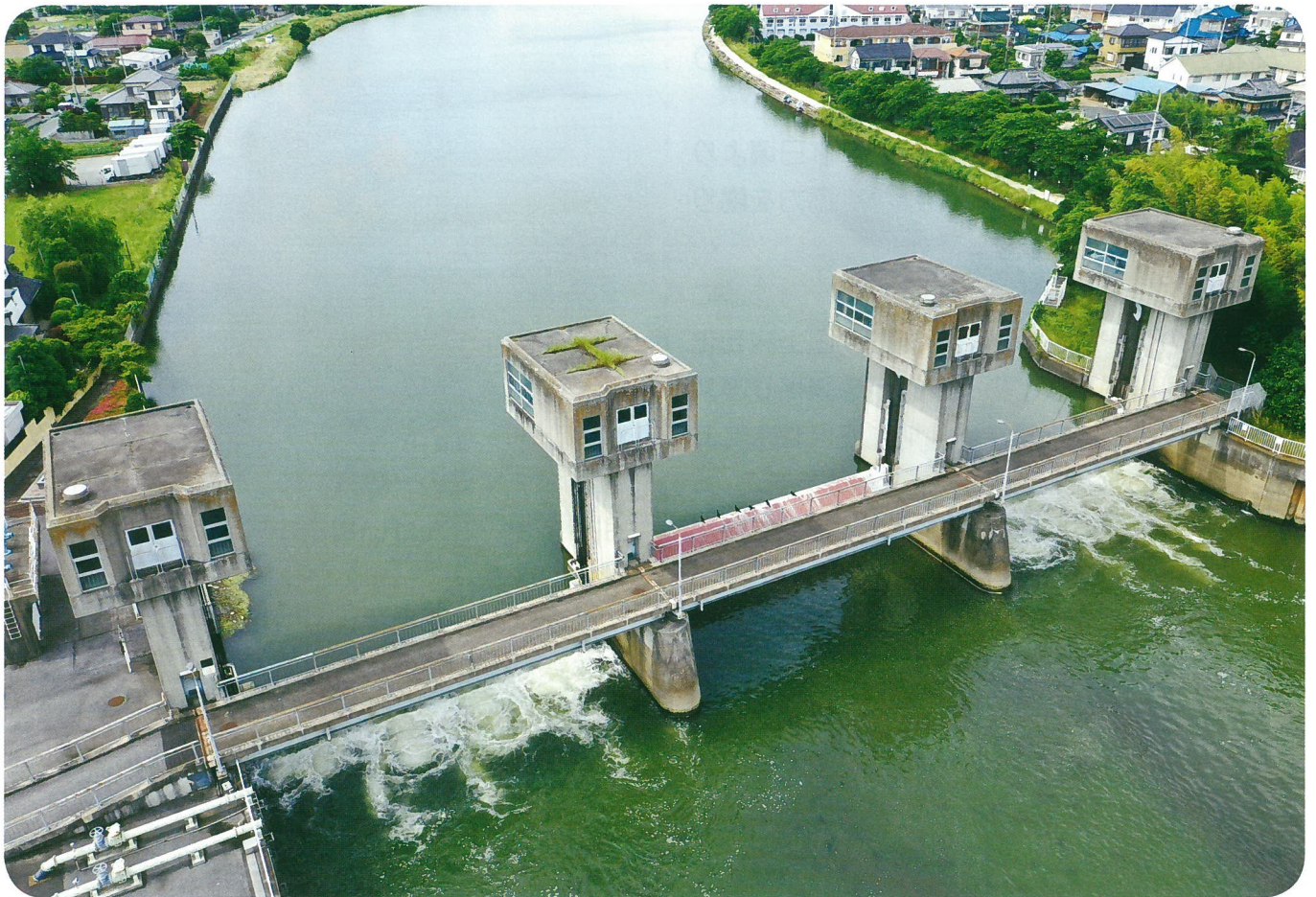
上空より古利根堰を望む (越谷市大字大吉 / 松伏町大字松伏地内)
